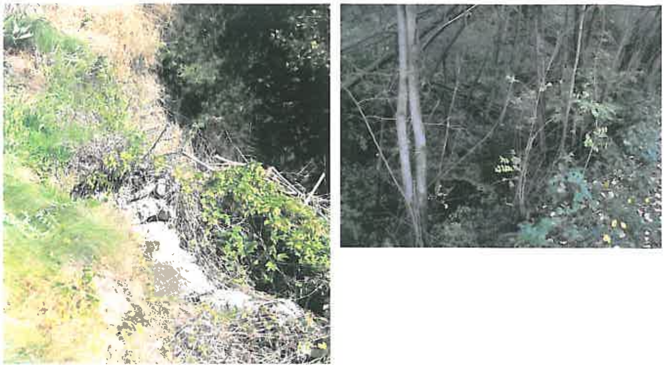
Abb. 6: links: aktive flachgründige Rutschung bergseitig der Steilwand; rechts: Graben zwischen Etschdamm und Hangfuß
